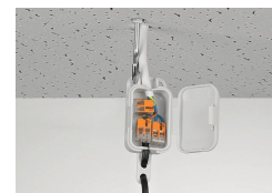
Conexión de lámpara en falso techo
